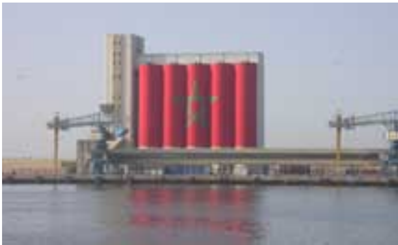
Silos à Céréales du port d'Agadir
