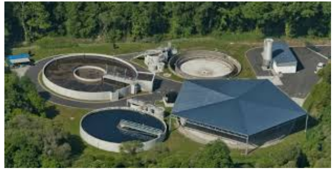
Station de traitement des eaux usées de Lemzar
